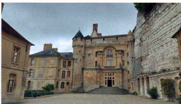
L'entrée du château
