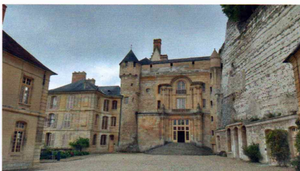
L'entrée du château
